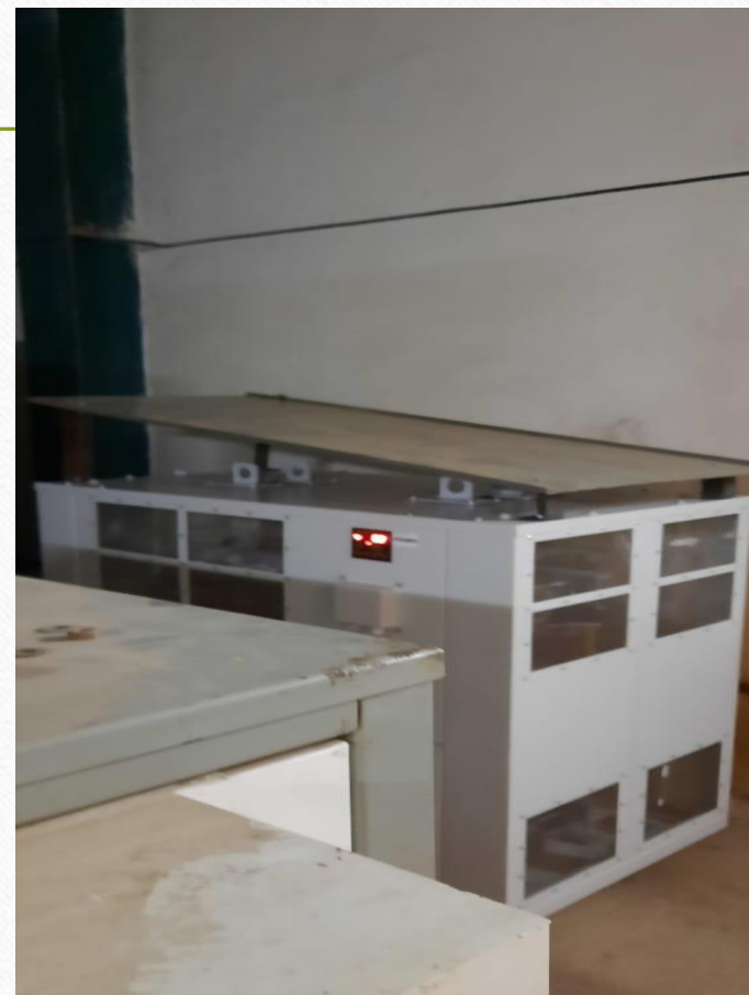
2.6 Трансформатор силовой мощностью 250 кВА
